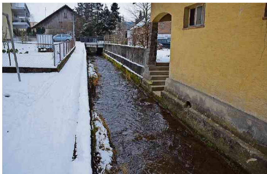
Unterhalb der Kreuzbergbrücke sind die Eingriffsmöglichkeiten beschränkt.
